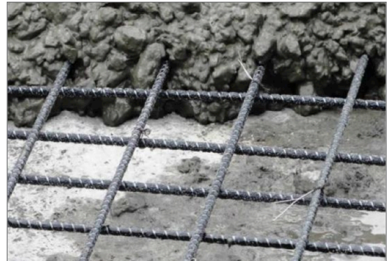
▲ استخدام قضبان ألياف البازلت كبديل لحديد التسليح في الخرسانة
